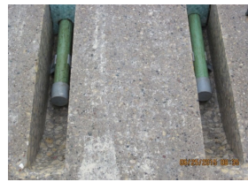
Dowel Bar Retrofit
