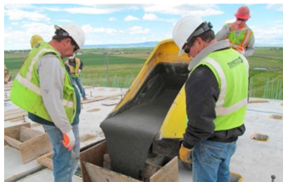
Workers pouring UHPC
