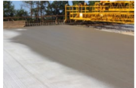
Bridge deck pour with ICC
