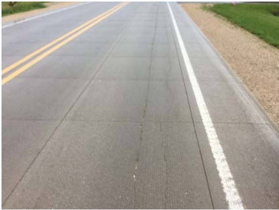
Longitudinal Cracks
