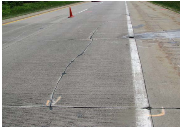
Longitudinal Cracks
