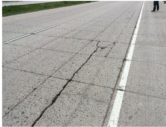
Longitudinal Cracks
