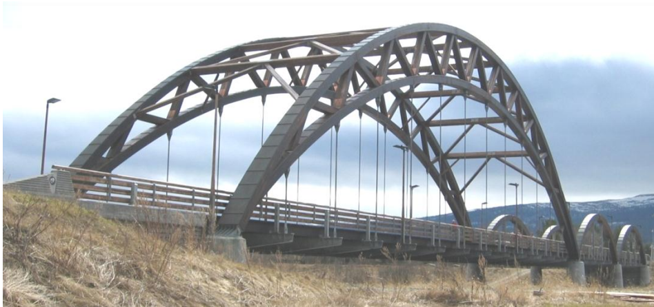
Tynset bridge, Norway (photo: K. A. Malo)
