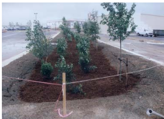
(d) New bioretention area after construction
